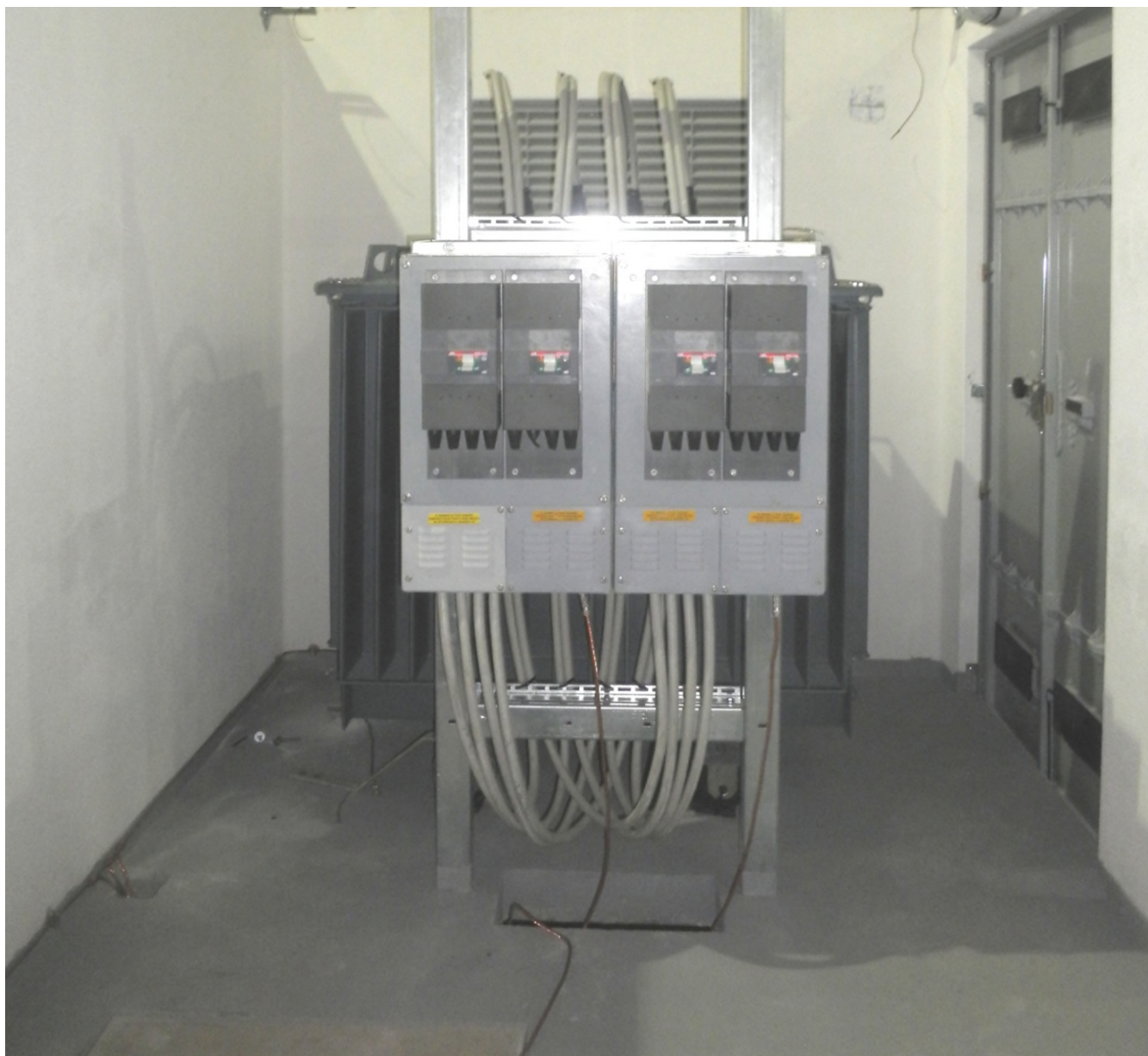
Esempio quadro BT installato
